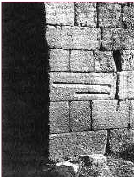
3. Medidas da vara e do côvado impressas no granito, Sortelha.
