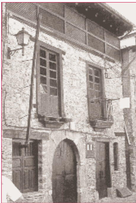
Rúa das Angustias nº 5. Adega rehabilitada. Conxunción de madeira e cachotería de pedra. As doelhas do portón están feitas en lousa.
